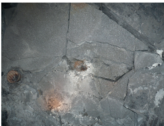
Рис. 4. Общий вид разрушенной породы в забое подрывки при разделке габаритов рельсового пути
