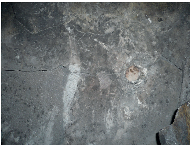
Рис. 3. Магистральная трещина между шпурами с невзрывчатый разрушающим составом
