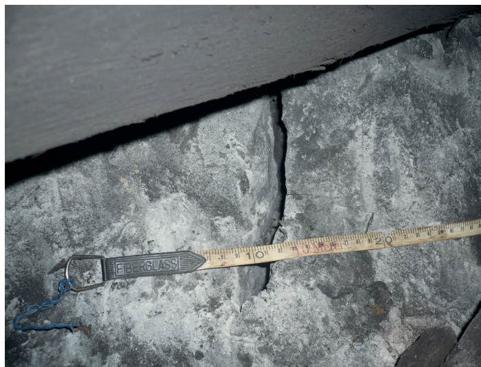
Рис. 5. Общий вид разрушенной породы в забое подрывки
